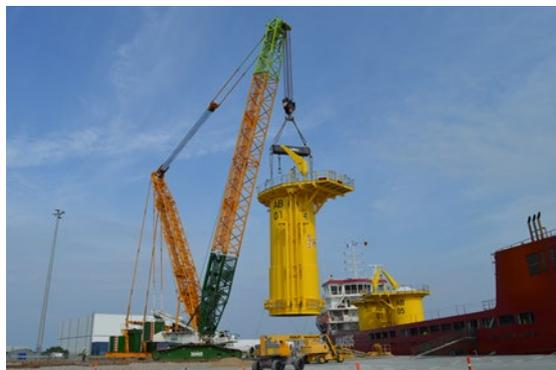
Umschlag u. Lagerung von Transition Pieces (Fundament einer Offshore-Anlage) / ©Fährhafen Sassnitz GmbH
