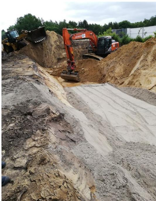
Projekt aus dem Sondervermögen des Landes "Sanierung ökologischer Altlasten M-V", Osmose Gelbensande (ehemaliger Holztränkplatz) entstanden bei der Hot-Spot-Sanierung des kontaminierten Erdwalls / ©GAA Gesellschaft für Abfallwirtschaft und Altlasten M-V mbH
